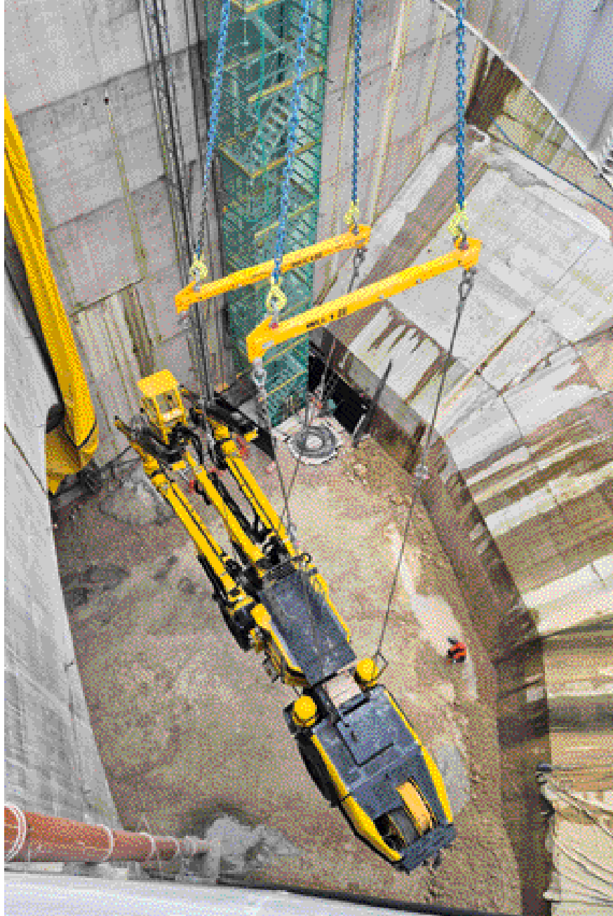
Il Boomer E20S è stato calato per circa 30 m da una gru, che viene utilizzata per lo smaltimento dello smarino e per movimentare tutte le macchine utilizzate in cantiere
