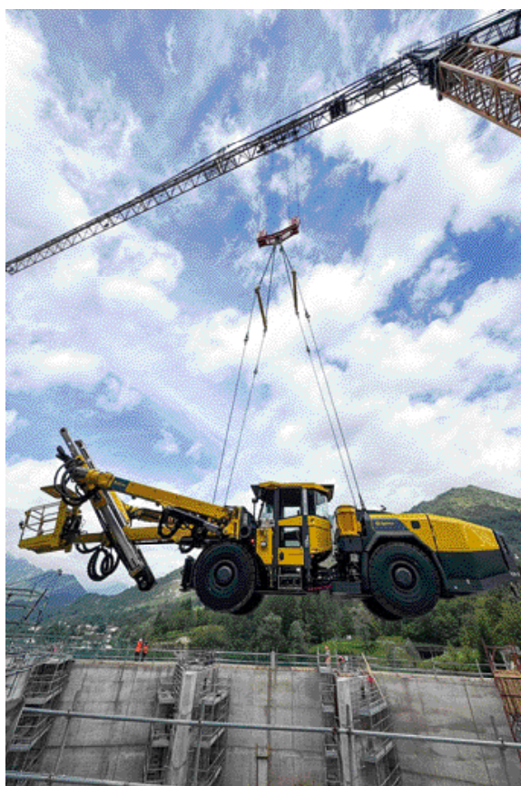
Il Boomer E20S è stato calato per circa 30 m da una gru, che viene utilizzata per lo smaltimento dello smarino e per movimentare tutte le macchine utilizzate in cantiere
