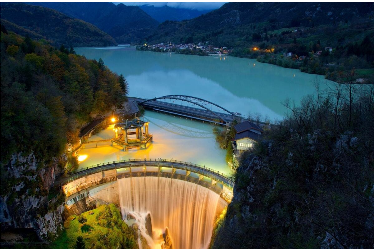
Lavori di adeguamento della Diga di Barcis (PN)
