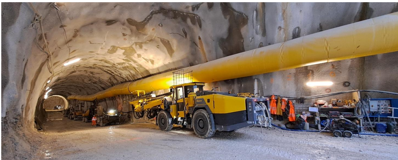
Scavo galleria presso la Diga di Barcis (PN)
