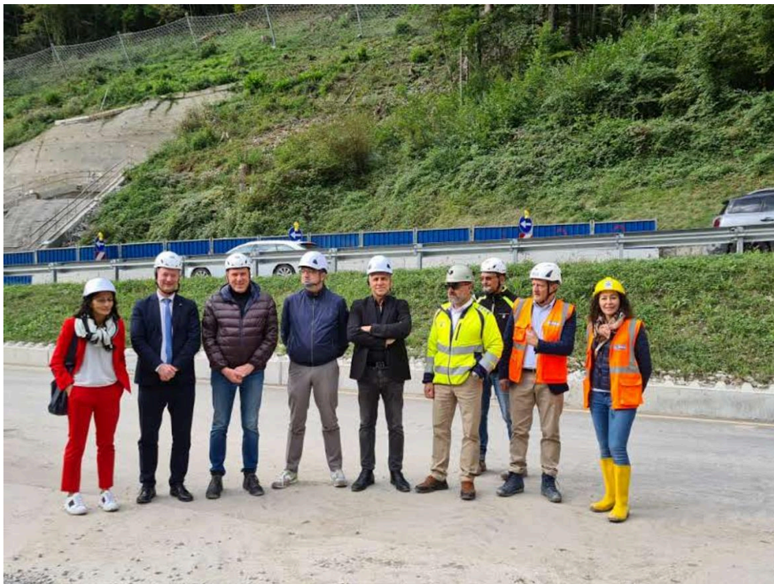
Galleria di Ponte Pià, iniziato lo scavo del nuovo tratto [ Archivio Ufficio Stampa PAT ]
