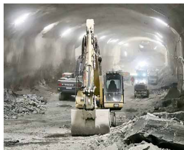
• Il garage in caverna: operazioni a buon punto
