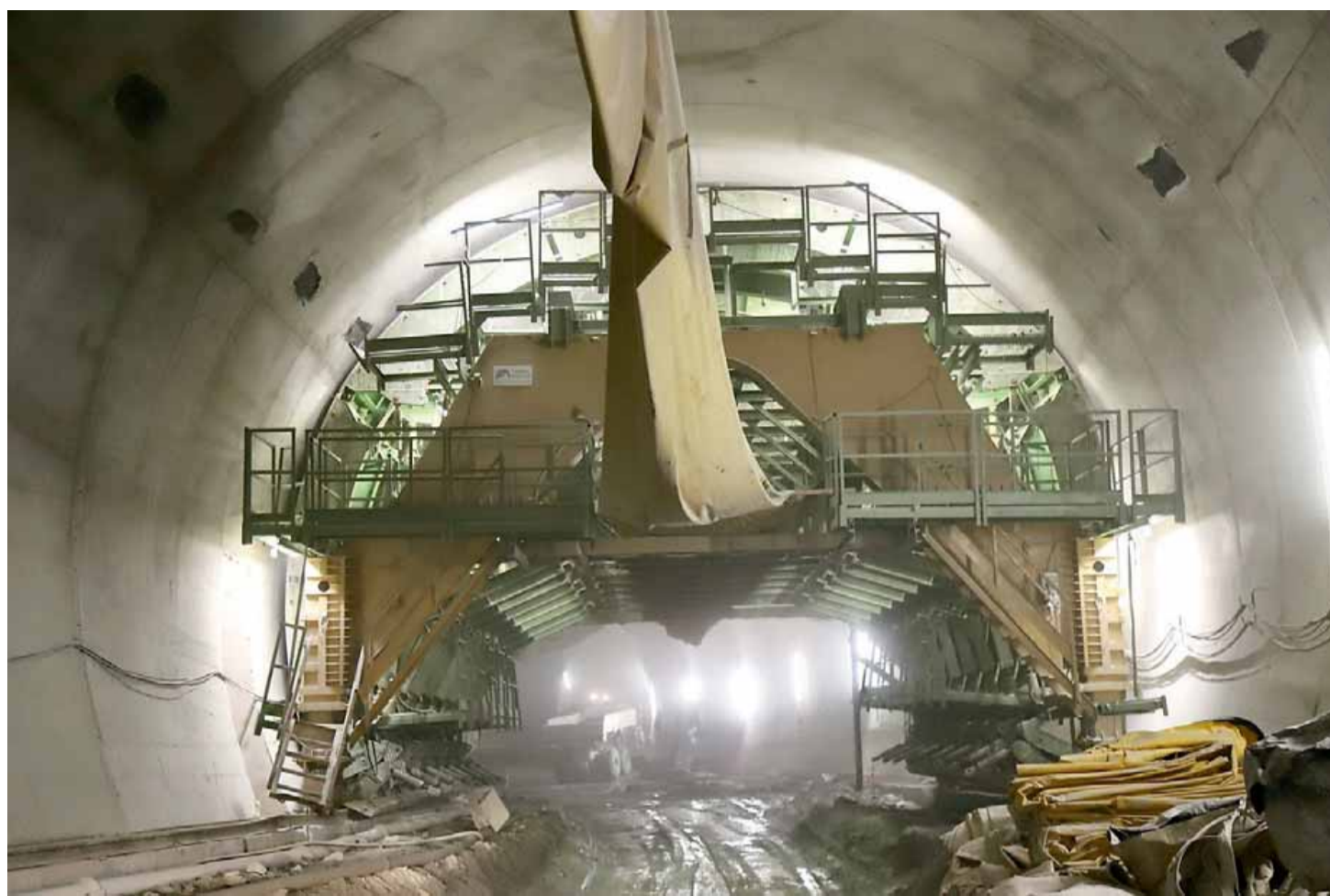
• Il lavori di consolidamento della volta FOTOSERVIZIO MILANESE
