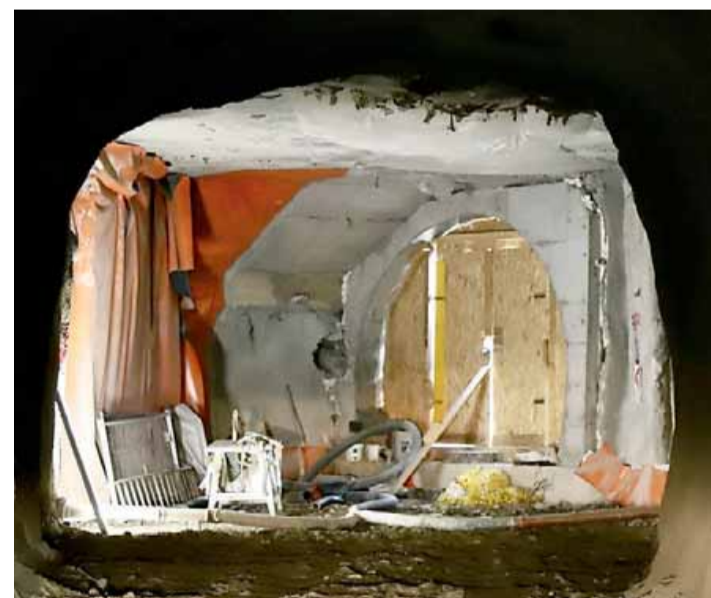
• L'uscita pedonale dall'autorimessa in via Galilei
