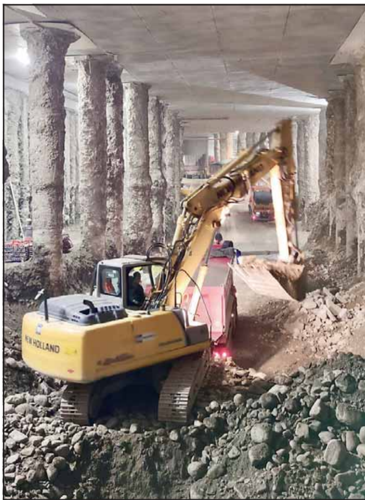
• Gli scavi sul versante della stazione
