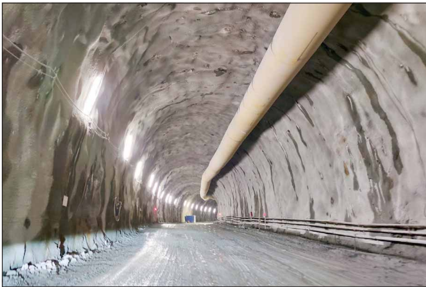
• La parte di tunnel realizzato partendo da Monte San Zeno (fotoservizio Milanese)
