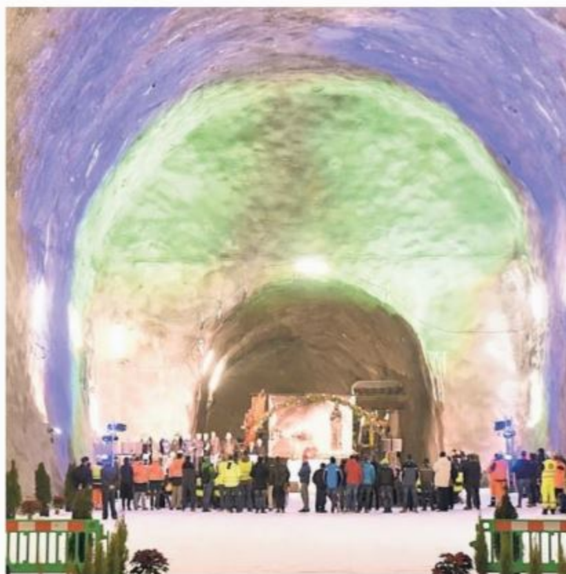
Pronti per dare il via ai lavori del lotto Mules-Brennero
